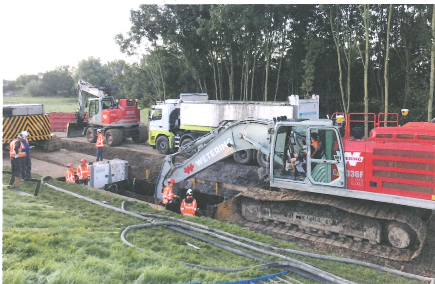
Ontgraven en afvoeren vrijkomend materiaal uit de sleuf
