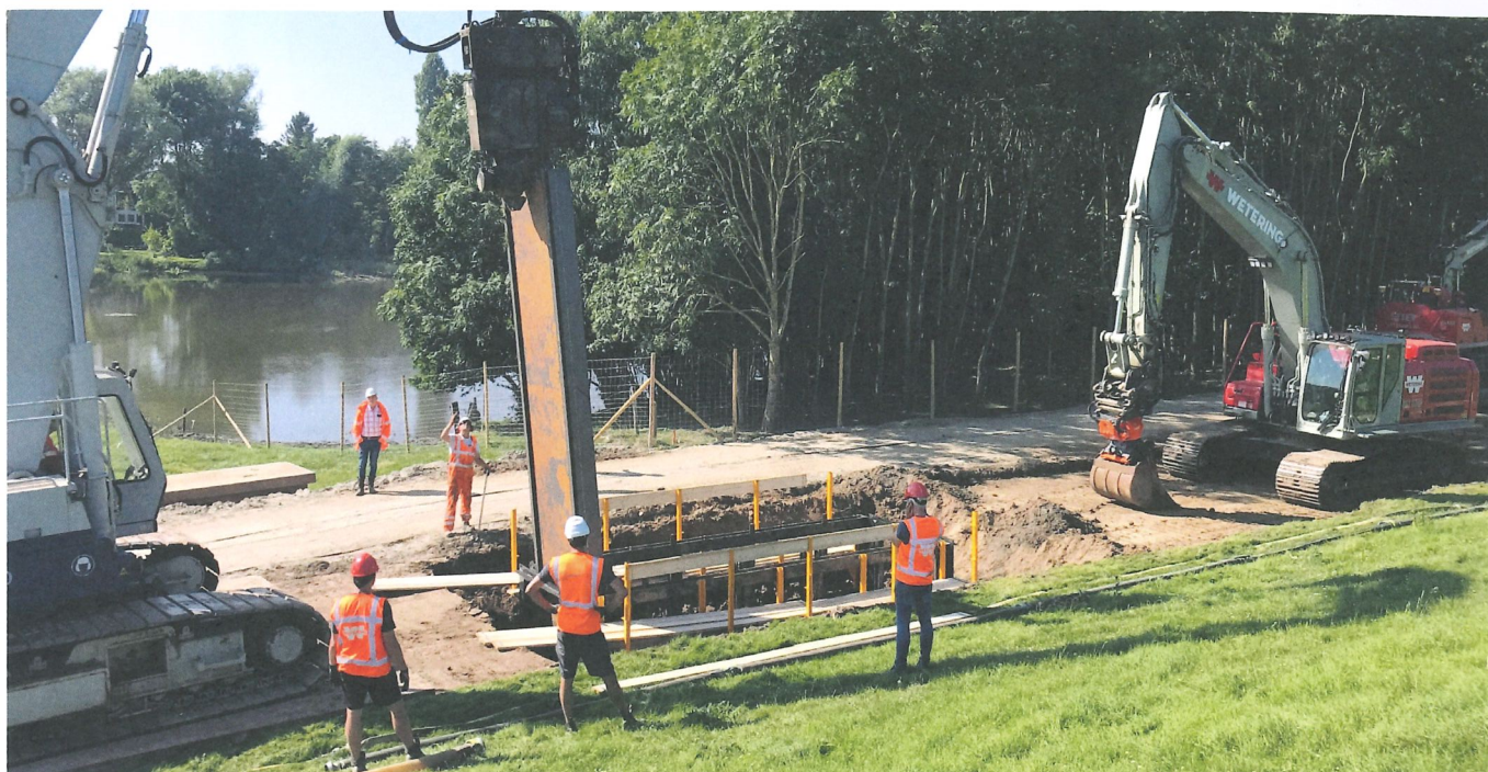
Plaatsen kopschotten damwandbox
