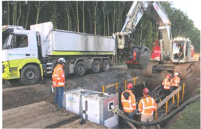
Nat ontgraven tot onderzijde sleuf.
