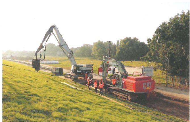
Overzichtsfoto materieelinzet aanleg GZB.
