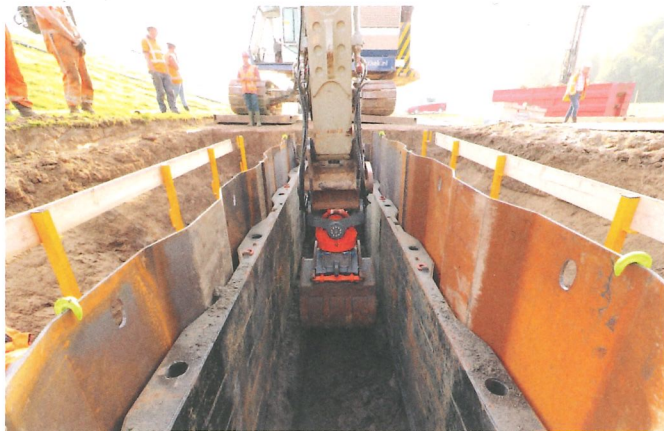
Afwerking afsluitende kleilaag.
